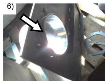
6) Lägg rökstosen i hålet
