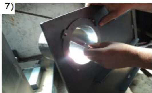
7) Montera tätningsbandet som har följt med vedspisen, montera tillbaka ringen och sen dra fast den med de fyra muttrarna
